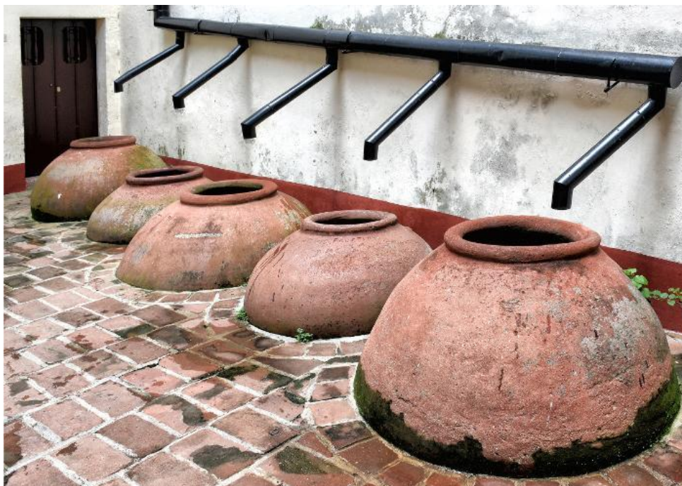
Ejemplo de sistema de cosecha de agua de lluvia tradicional utilizado en Camagüey
