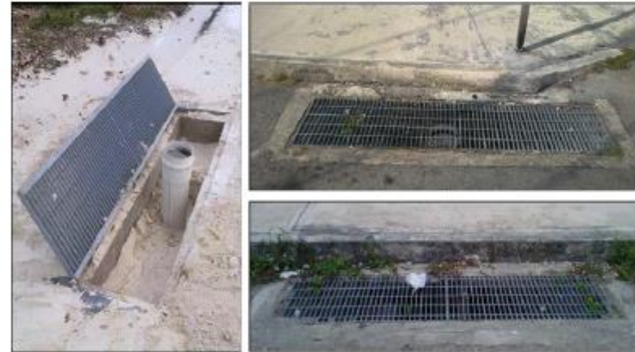
ZANJA COLECTORA PI (POZO INTERIOR)
