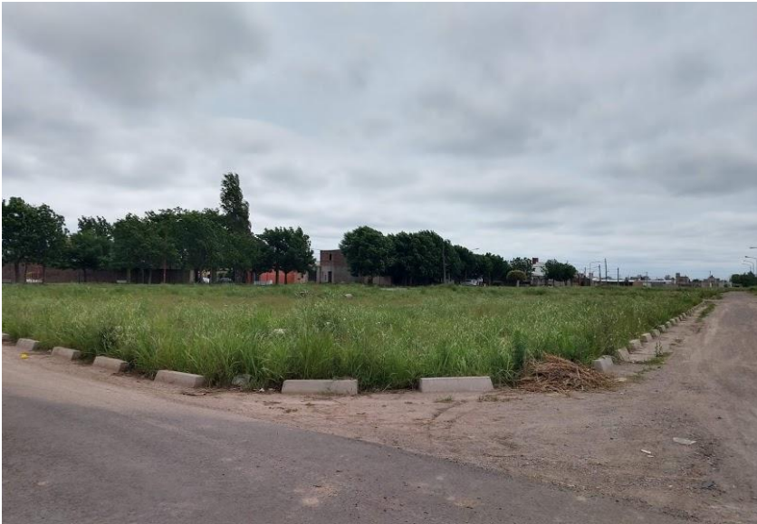
Retardadores pluviales en espacios públicos verdes.
