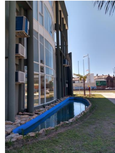
Edificio con retardador pluvial lateral
