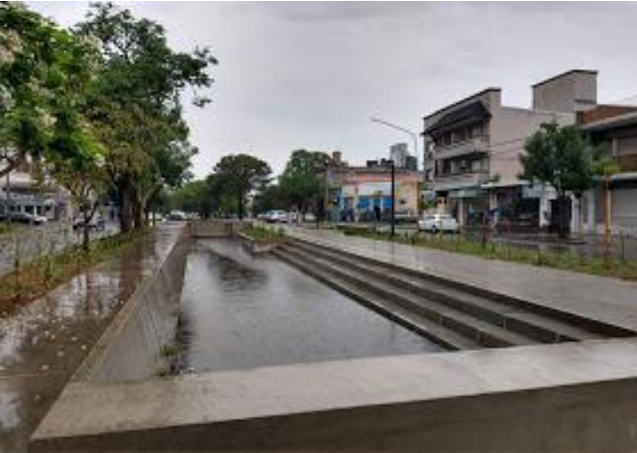
Retardador pluvial a cielo abierto en intersección Av. Freyre y Catamarca Fuente: Maldonado, 11/2019
