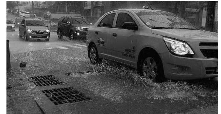
La Canalización de la Calle 84 en Funcionamiento (El tiempo, 2016)
