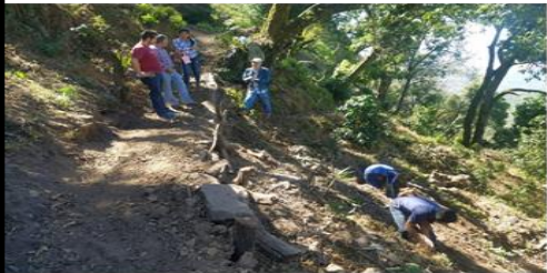
Construcción de terrazas/barreras vivas
