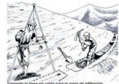
Trazando la línea sin caída para la zanja de infiltración.
