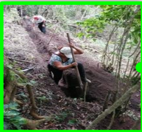
SbN: Zanjas de infiltración
