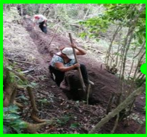
SbN: Zanjas de infiltración
