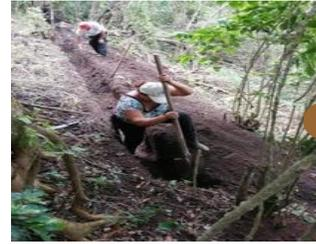
Zanjas de infiltración
