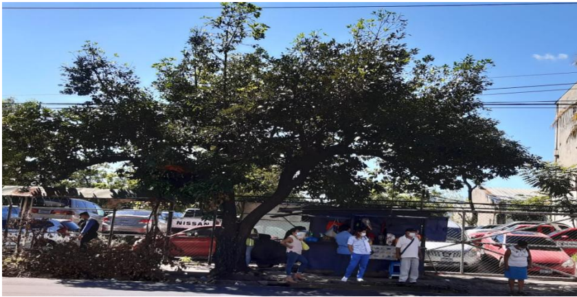
Figura 12. Daño de tendido eléctrico por ramas Calophyllum brasiliense en la calle Rubén Darío
