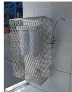
Fig. 2 Elementos de sistema de captación de agua lluvia en centros Escolares. Tanque de 10,00 litros, bomba y grifo con su respectivo filtro.
