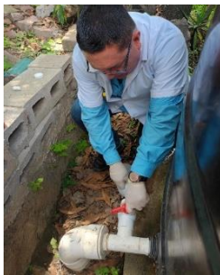
Fig. 2 Elementos de sistema de captación de agua lluvia en centros Escolares. Tanque de 10,00 litros, bomba y grifo con su respectivo filtro.
