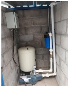
Fig. 2 Elementos de sistema de captación de agua lluvia en centros Escolares. Tanque de 10,00 litros, bomba y grifo con su respectivo filtro.
