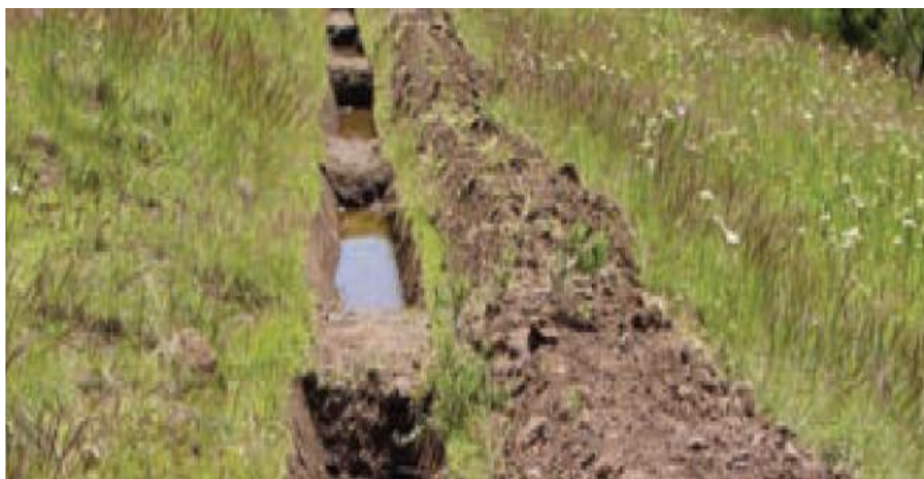
Figura 2.6. Ejemplo de una acequia a nivel. Tomado de (CONAFOR, 2007).
