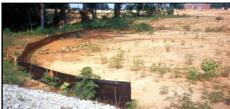
Figura 2.3. Ejemplo de barrera de sedimentos de geotextil. Tomado de (CDOT, 2019).
