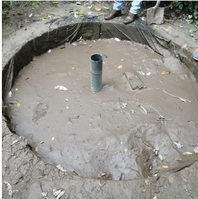
Figura 4.8. Acumulación de lodo en pozo 4 después de una tormenta.
