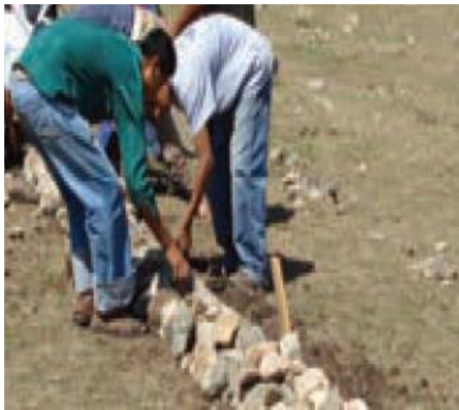
Figura 2.4. Barrera muerta de piedra. Tomado de (CONAFOR, 2007).
