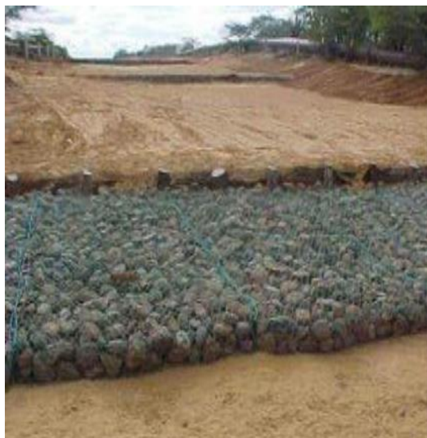
Figura 2.7. Cama disipadora de energía de piedra. Tomado de (Villamarín, 2013).
