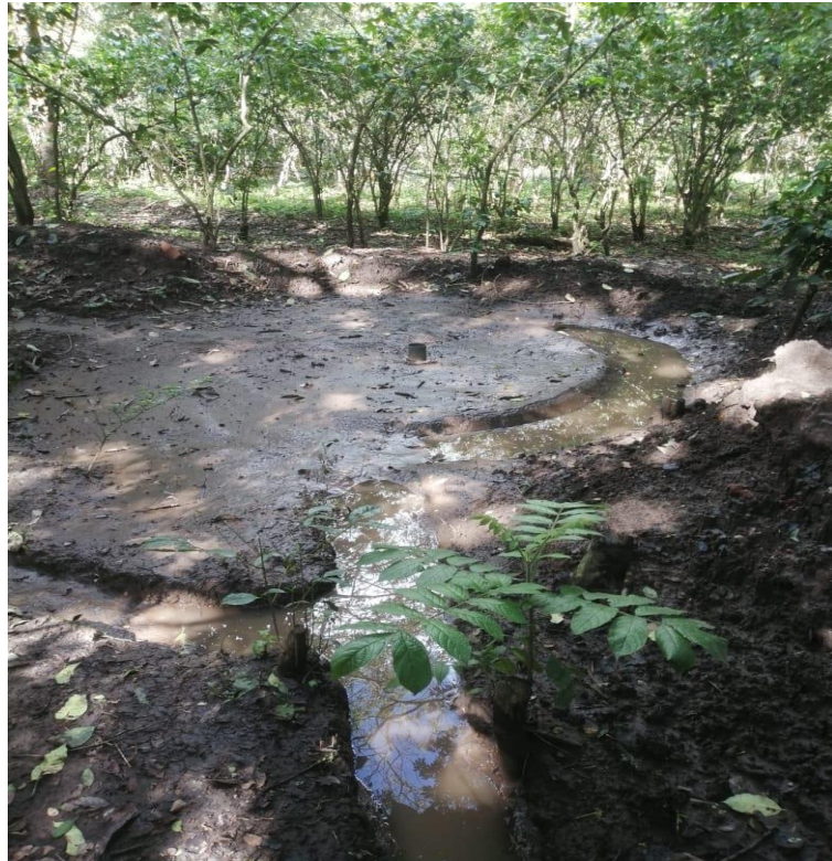
Figura 3.11. Uno de los pozos de absorción cubierto por sedimentos.
