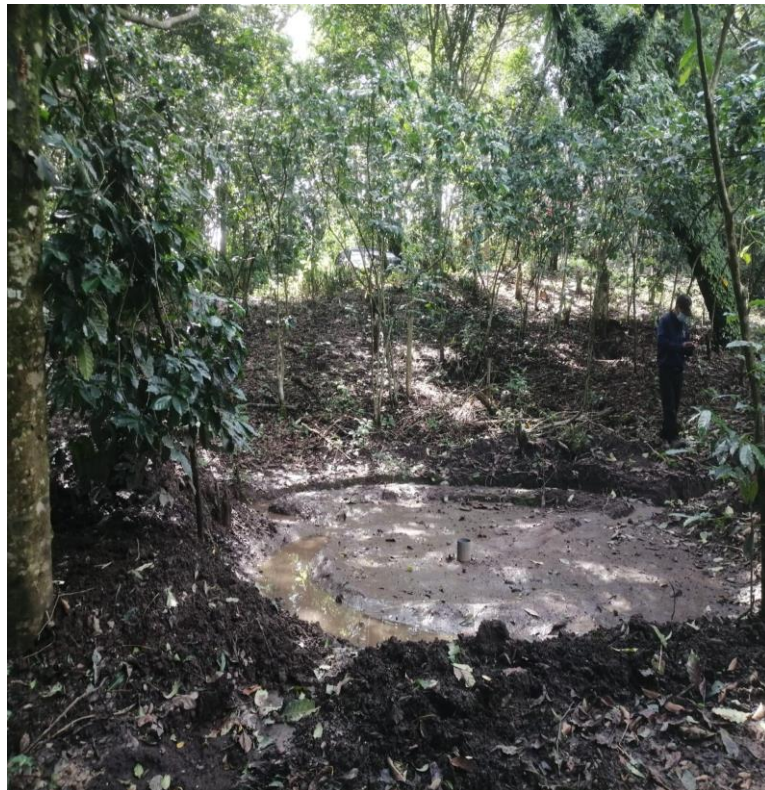
Figura 3.12. Otro ejemplo de pozo de absorción cubierto por sedimentos.
