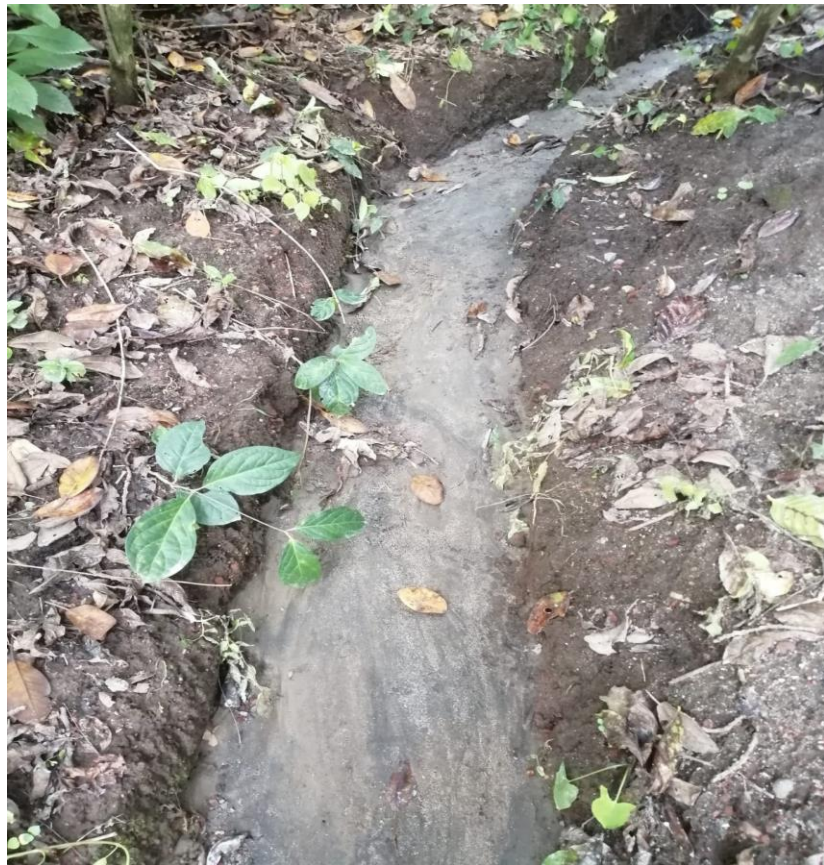
Figura 3.10. Una de las canaletas del pozo 4 cubierta de sedimentos.
