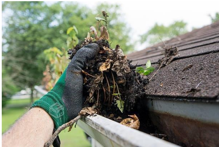
Figura 5.9 Retiro de hojas de canal de aguas lluvias. Fuente: [Pedro Mendoza, (2024)]
