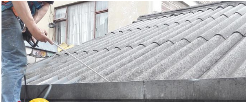
Figura 5.11 Lavado de canal de aguas lluvias. Fuente: [La Molina, (2019)]
