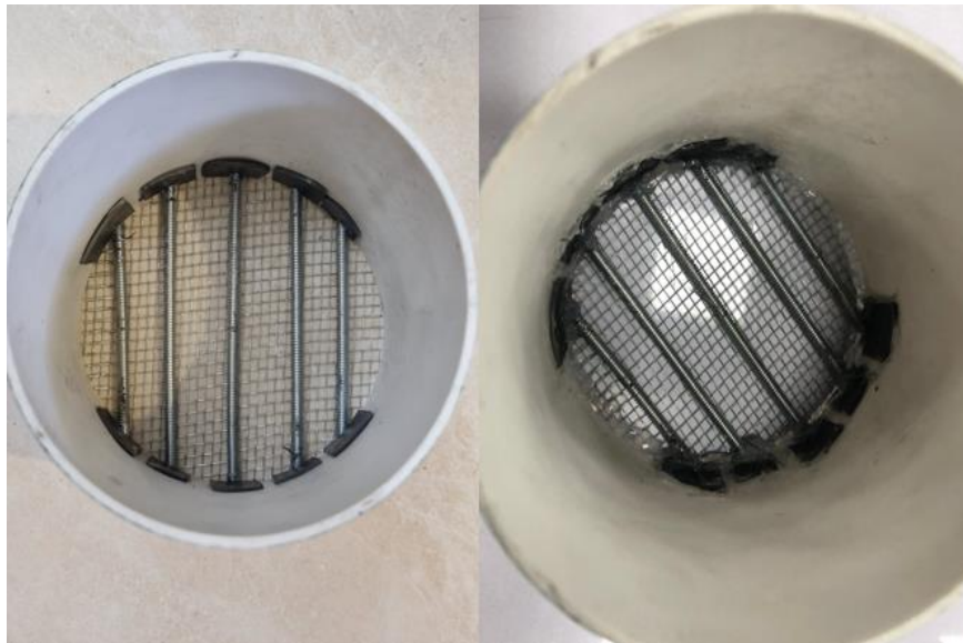
Figura 3.32 Instalación de la base reforzada de PVC con varillas corrugadas y malla galvanizada. Fuente: [Elaboración propia (2025)]
