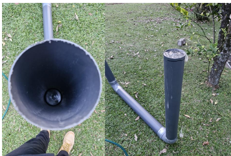
Figura 3.16 Demostración del funcionamiento del sifón del SCALL. Fuente: [Elaboración propia (2025)]
