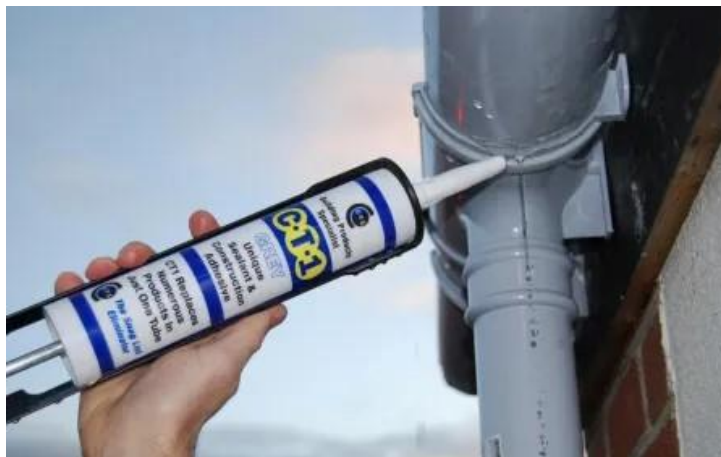
Figura 5.12 Reparación de goteras o fisuras en canal de aguas lluvias. Fuente: [Canalones Burgos, (2023)]
