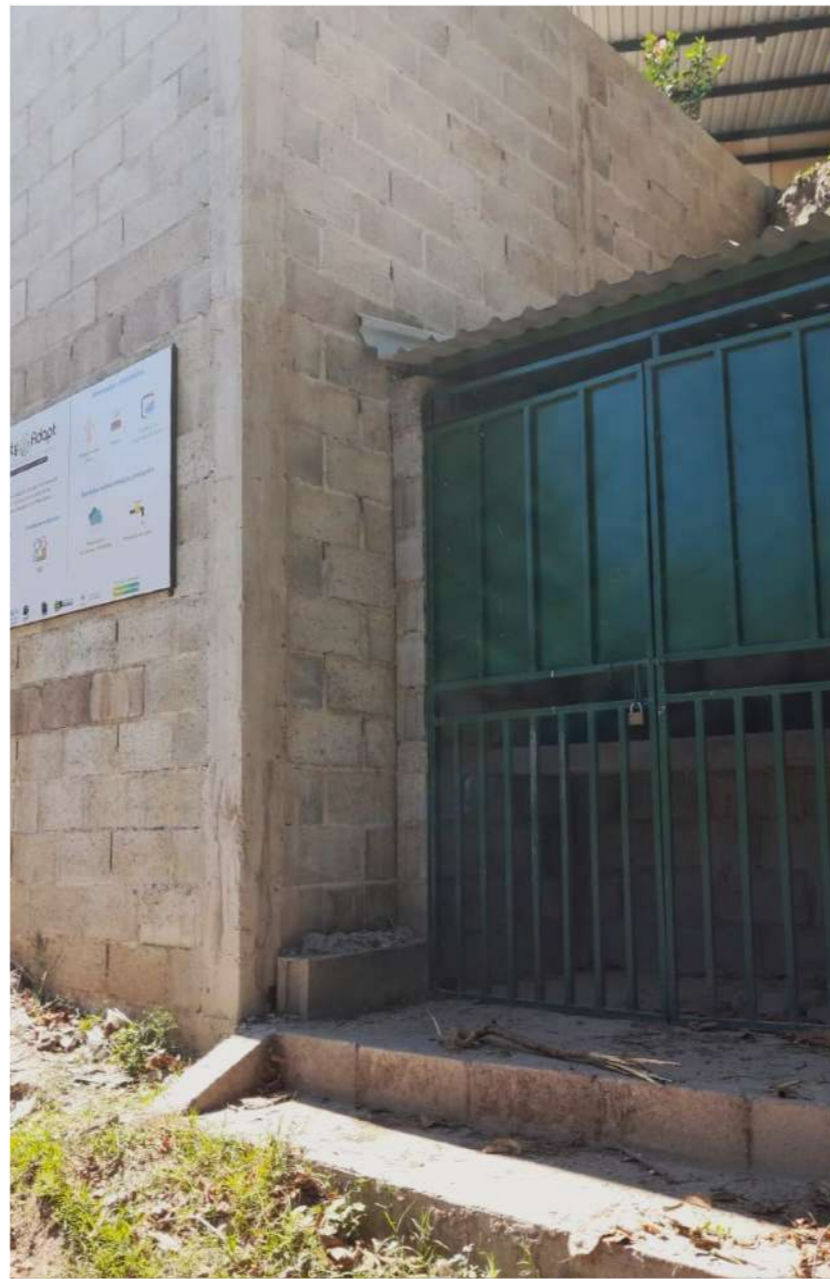
1 sistema de cosecha de agua comunitario de 54.75 m 3
