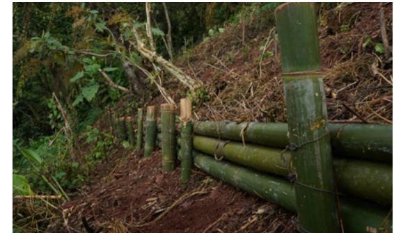
Barrera de bambú para retención de suelos.
