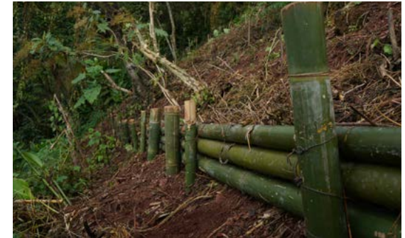
Barrera de bambú para retención de suelos.
