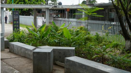
Los jardines de infiltración consisten en una depresión (natural o artificial) que recolecta el agua superficial que fluye de los techos, carreteras, aceras y otras superficies urbanas impermeables o semipermeables después de eventos torrenciales de lluvia. Esta depresión, y las capas debajo de la superficie, permiten una evacuación parcial o total del agua en un sistema de drenaje subterráneo.
