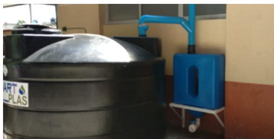
Los sistemas de captación de agua de lluvia (SCALL) permiten la captación de agua de lluvia de techos (particulares o de edificios comunitarios) mediante canales y tubos que la guían a un tanque o cisterna, pasando antes por un filtro (y otros tratamientos según el uso) que limpia y habilita el agua para el consumo particular o comunitario. El sistema también puede fortalecer la comunidad a través del manejo colectivo del agua para la producción agrícola, cuidado de animales e higiene.
