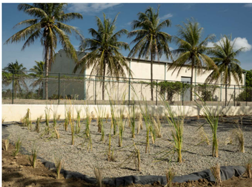
Figura 1.- Humedal artificial de flujo subsuperficial Fuente: Fondo de agua Yaqué del Norte
