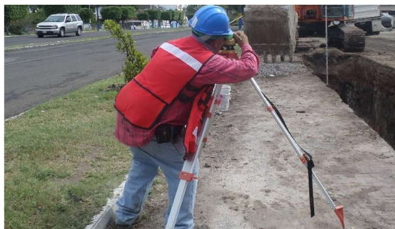
Figura 5. Limpieza trazo y nivelación Fuente: https://fotos.habitissimo.com.mx/
