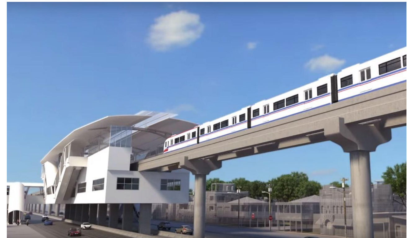
Figura 5. Ejemplo de Estación Línea 3 del Metro de Panamá
