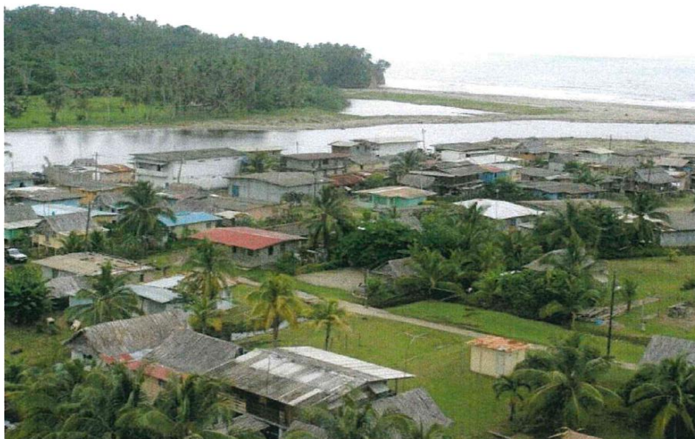
Vista aérea del Municipio de Donoso, donde se observa la falta de planificación y ordenamiento territorial
