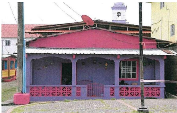
Tipología de viviendas en Portobelo
