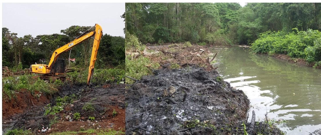
Figura 11. Imagen de los trabajos realizados en el Río La Ensenada
