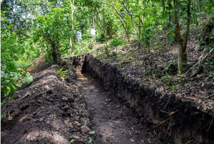
Figura 2. Terracería para caja de recolección de sedimentos.
