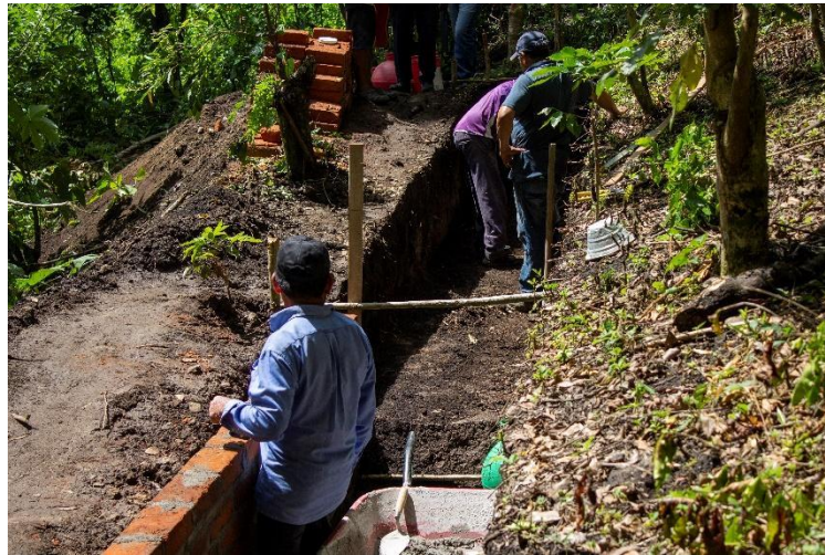
Figura 4. Construcción de paredes laterales en la caja de retención de sedimento.
