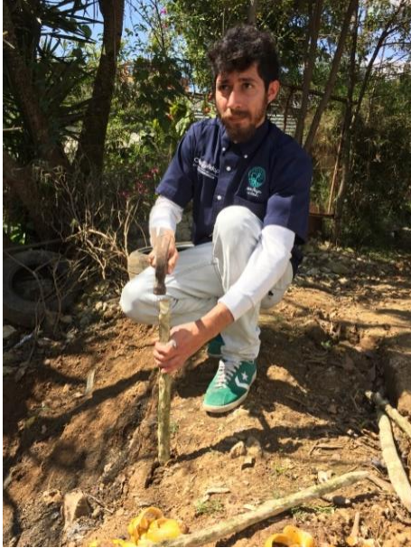
Foto 16. Enterrado de estaca para el trazado en el punto 9.
