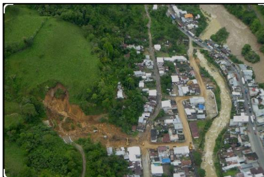
Figura 26. Imagen de Alluriquín (deslizamiento)
