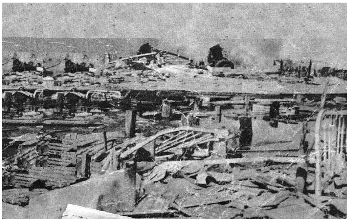
Figura 9. Derrumbes en Santa Cruz del Sur tras el impacto del huracán de 1932
